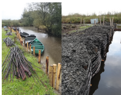
Exemple de travaux de fascinage
