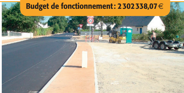
Aménagement rue de la haie / rue des rochettes
