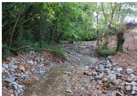
Exemple de travaux en recharge granulométrique (apport de cailloux)
